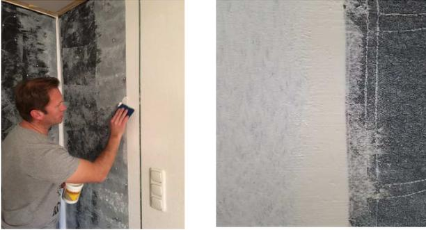
Sollte das Vlies ohne weiteren Kantenabschluss montiert werden, empfehlen wir den Übergang vom Vlies zur Wand mit einer geeigneten Spachtelmasse in einer Breite von ca. 2-3 cm anzugleichen, damit sich der Stoß nach der Endbeschichtung nicht abzeichnet.
