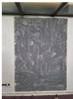
Nun grundieren Sie die Wand / Decke per Rolle richtig satt mit **WEMA-Bon**. Dazu das Vlies zurückschlagen bzw. noch einmal von der Wand nehmen. Dann drücken Sie das Vlies fest in die nasse Grundierung. Mit der mit **WEMA-Bon getränkten Rolle das Vlies abrollen**. Es dürfen keine Blasen hinter dem Vlies sein. Das Vlies muss satt mit WEMA-Bon getränkt sein. Evtl. nochmals die Ecken und Kanten leicht abziehen und dahinter mit WEMA-Bon einrollen.
