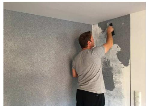
WEMA Flüssigtapete muss nun restlos abtrocknen. Mit einem Ventilator kann dies beschleunigt werden. Trocknungszeit je nach Witterung 48-72 Std. **Achtung!!! Einschalten erst nach kompletter Trocknung!**
