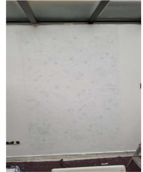
**Achtung! Nicht einstecken bis das Vlies bis in den Untergrund abgetrocknet ist, da sonst die LED-Leiter oxidieren können. Erst im trockenen Zustand ist eine kurze Sichtprüfung vor der Beschichtung mit WEMA Flüssigtapete möglich. Nicht länger als 30sec. eingeschaltet lassen.**
